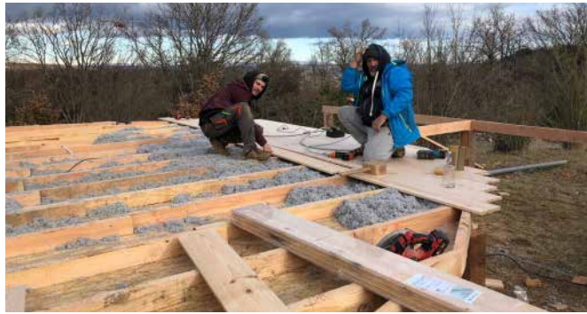
Isolation en ouate de cellulose
