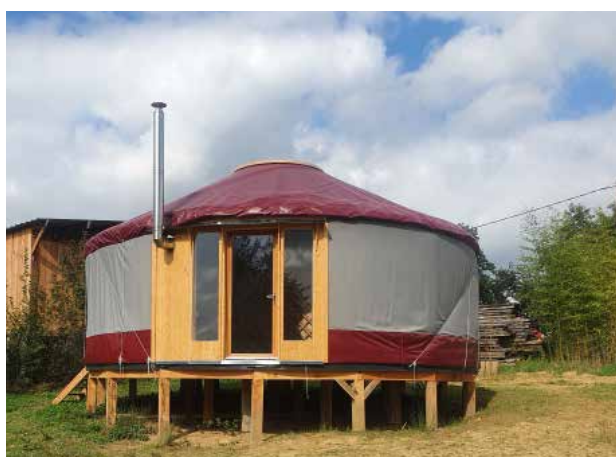
Sortie de poêle a bois sécurisé
