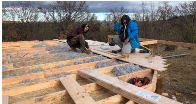
Isolation en ouate de cellulose
