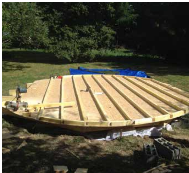
Solivage haut + osb, prêt à mettre l'isolation
